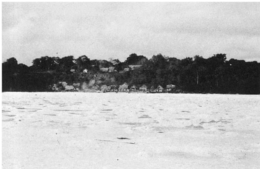
Sur la falaise, le village du haut, vu de la baie.
